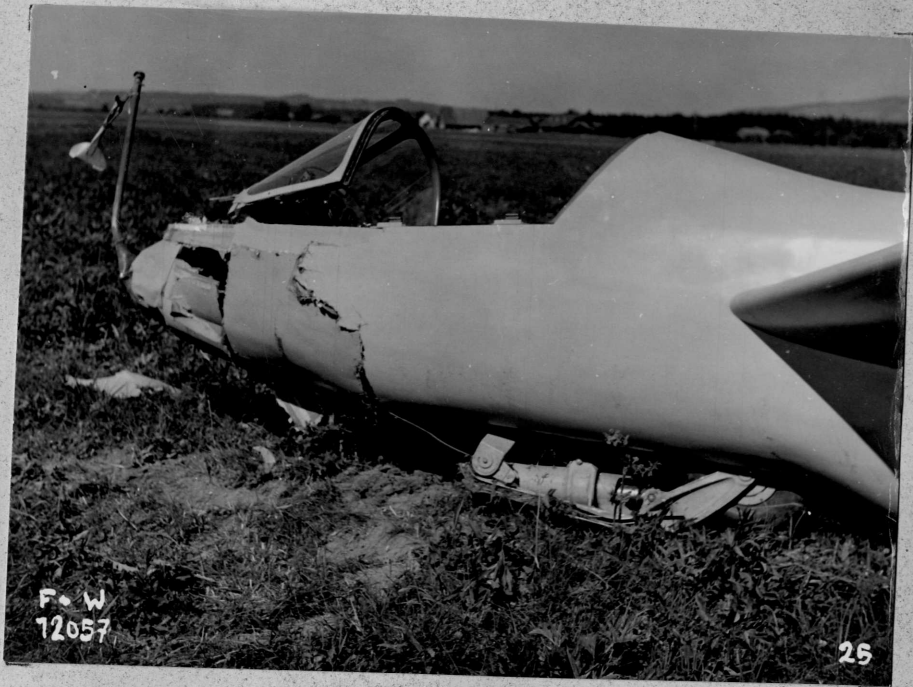
25 Zertrümmerter Kabinenvorderteil und eingeknicktes Bugrad
