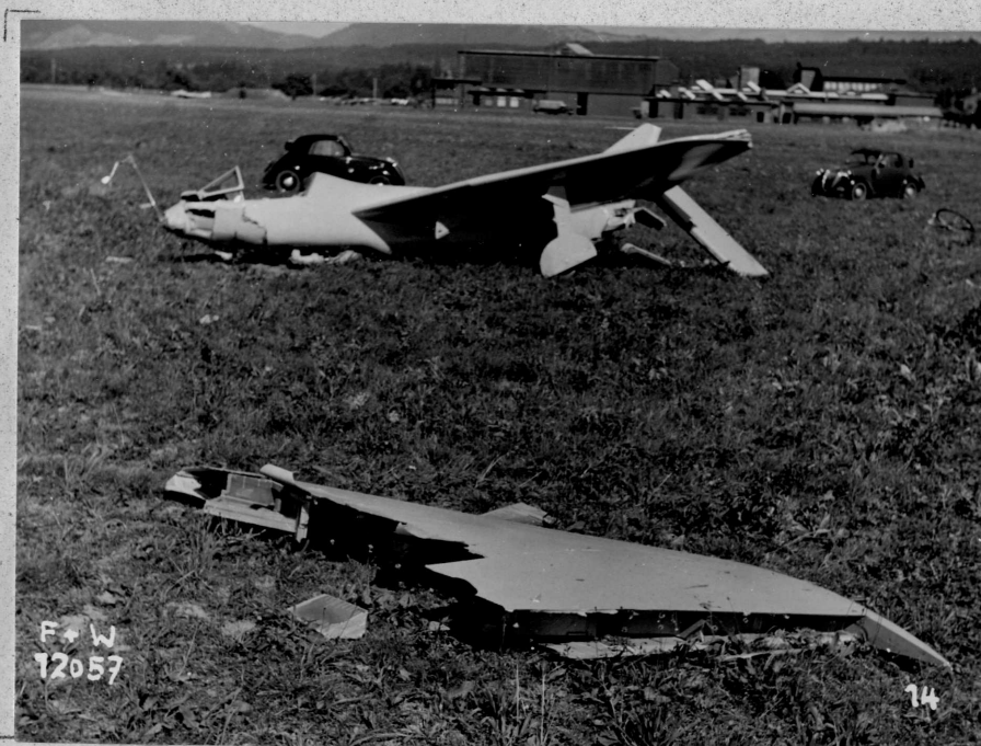
14 Abgerissener rechter Aussenflügel
