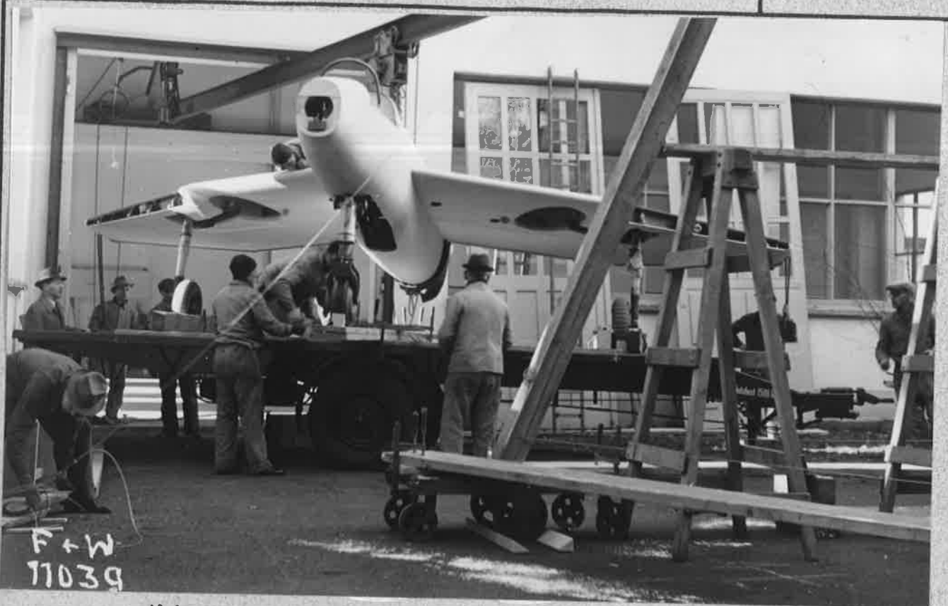
Abtransport des Gleiters aus Windkanal-Gebäude.
