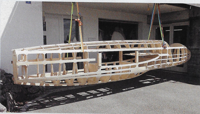
Rumpfbau des Nachbaus noch ohne Einbauten. | Gros-œuvre du fuselage de la coque de la réplique encore sans équipements.
