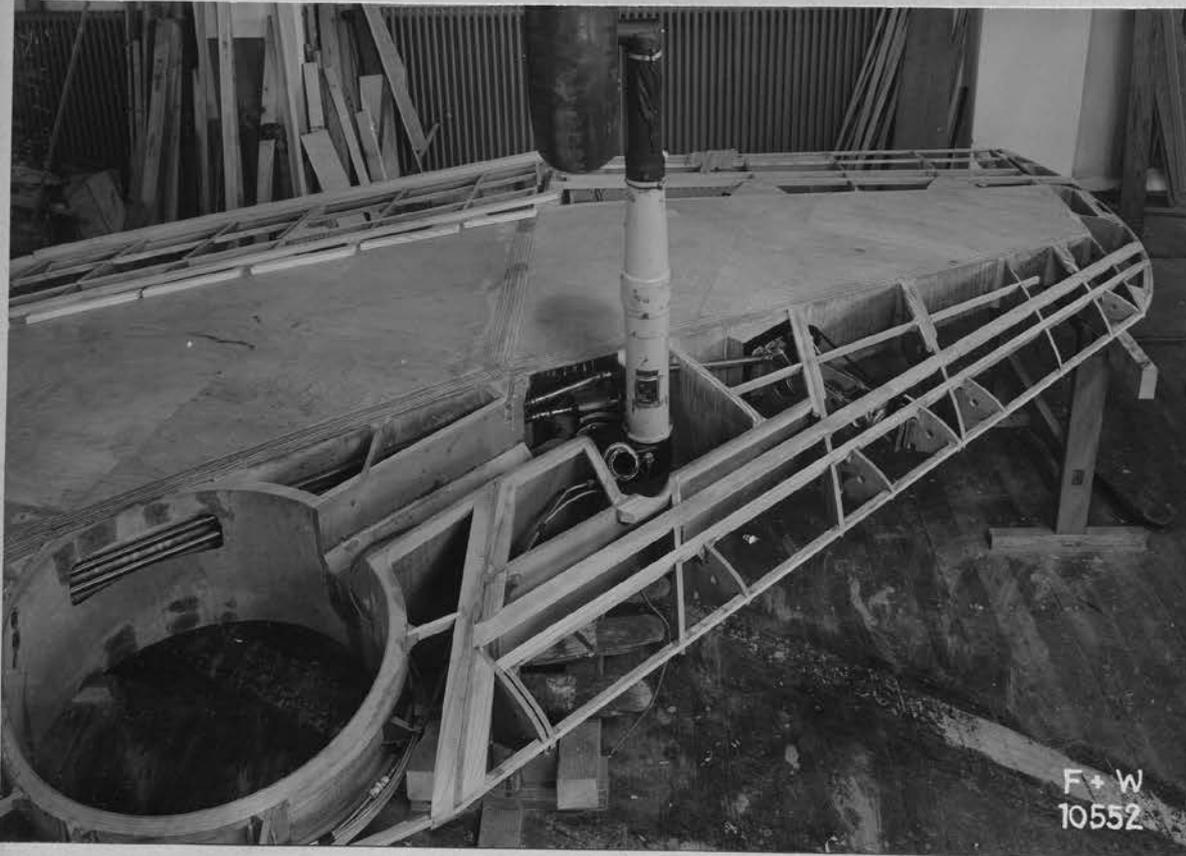
Flügel mit Nasenklappe und Fahrwerknische.
