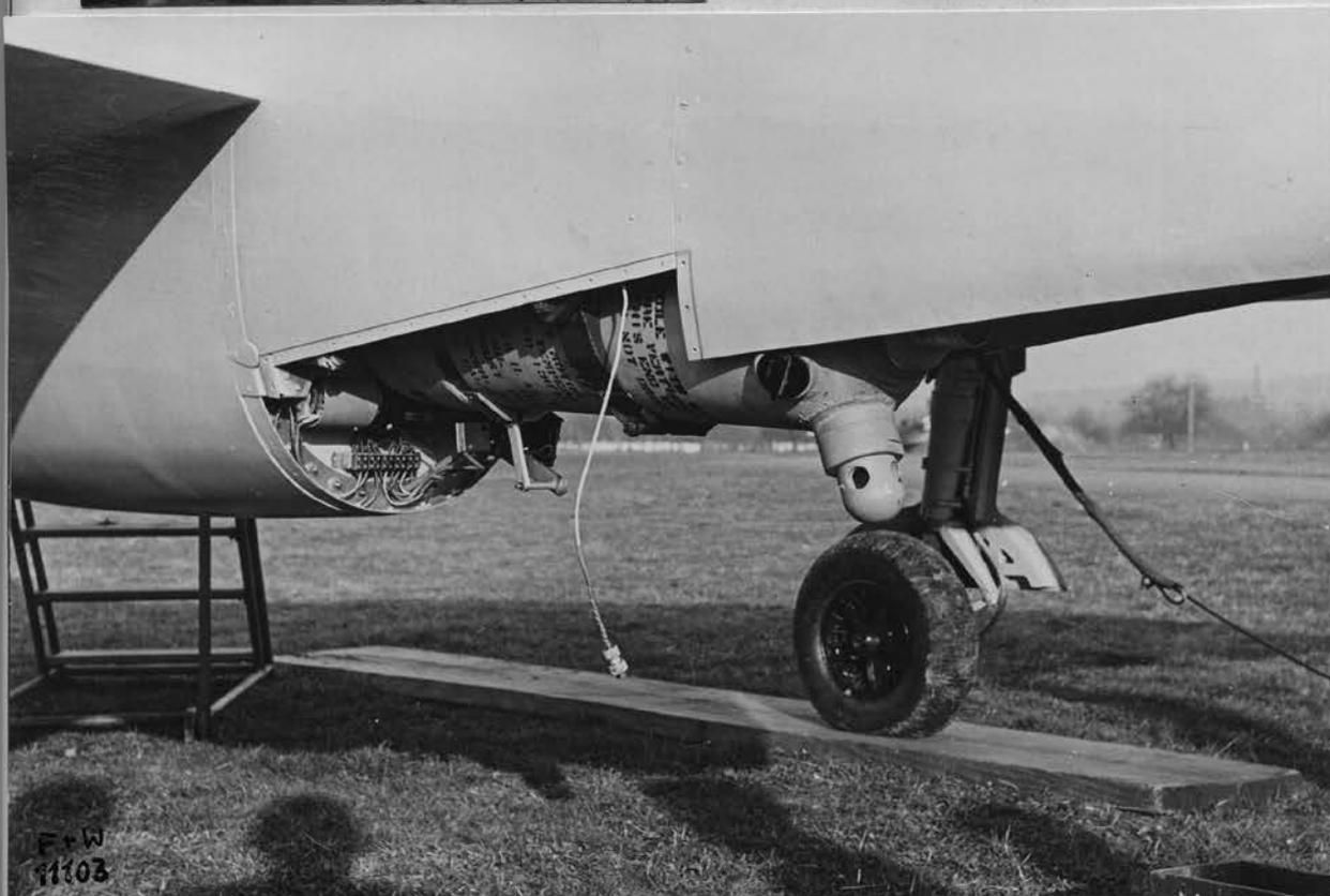
Rumpfheck mit montierter Rakete.
