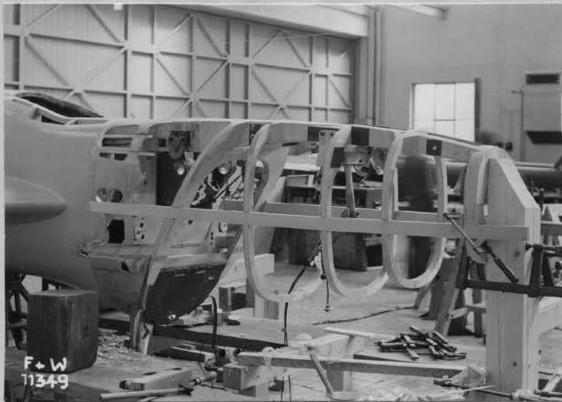
Reparatur des Kieles und Montage der Spanten im Rumpfbug.
